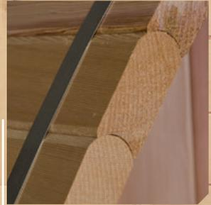
Ohne Verwendung von Nägeln wird das Risiko von Rissen vermindert, da sich das Holz innerhalb den Stahlbändern bewegen kann.
